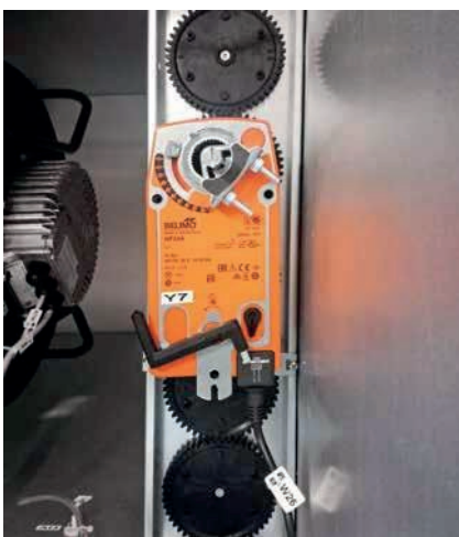
Slika 55: Pogon loput za sveži in odvodni zrak.
