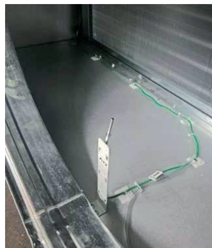
Slika 53: Tipalo temperature dovodnega zraka. Priključi se v priključni dozi, ki se nahaja za dovodnim ventilatorjem (zeleni konektor, gl. Sliko 54).
