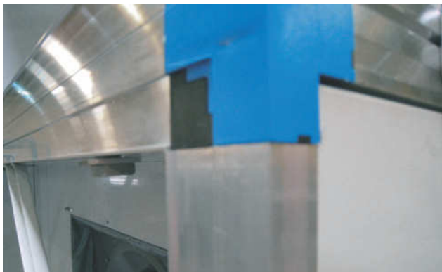
Слика 14: Применити самолепљиву EPDM гумену заптивну траку са поперечним пресеком 20 x 8 мм (испоручује се са клима комором) на контактну предњу површину (рам кућишта), када се повезују секције са алуминијумским профилем.
