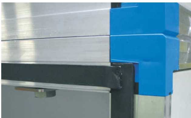
Слика 15: Заптивна трака мора се преклопити на угловима. Приликом спајања две секције, применити траку за заптивање само на једну од секција.
